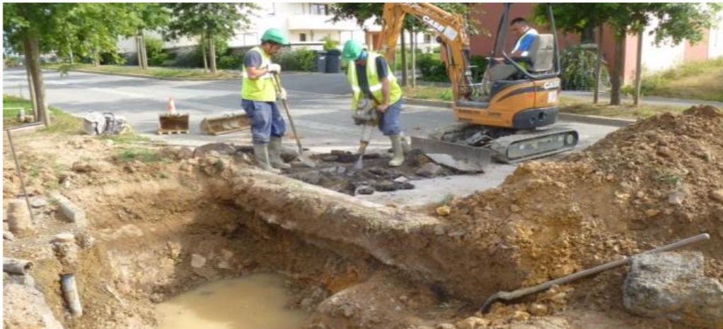
Les techniciens de la Saur ont creusé pour localiser les canalisations à réparer. | Photo : DR.
