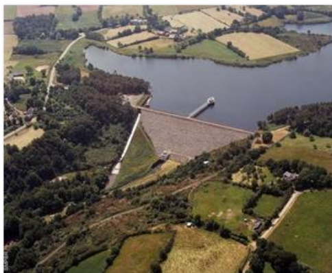
Barrage de la Chêze
