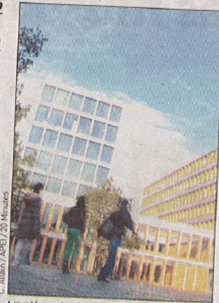
Le siège de Rennes Métropole à Clémenceau a été livré en 2007.
