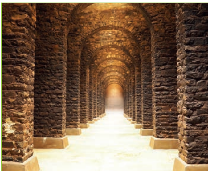
7 mètres sous terre, le réservoir des Gallêts.
